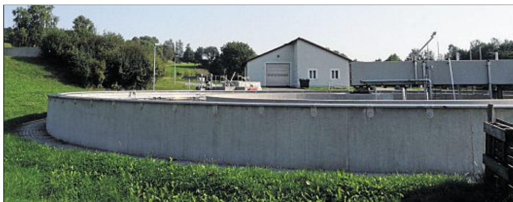
Im Zuge des 14 Millionen Euro teuren Abwasserprojektes wurde auch die neue Kläranlage bei Burgtreswitz errichtet. Die Abrechnung erfolgt jetzt. Die Beitragszahler werden nur noch ganz gering belastet. Bild: gi
